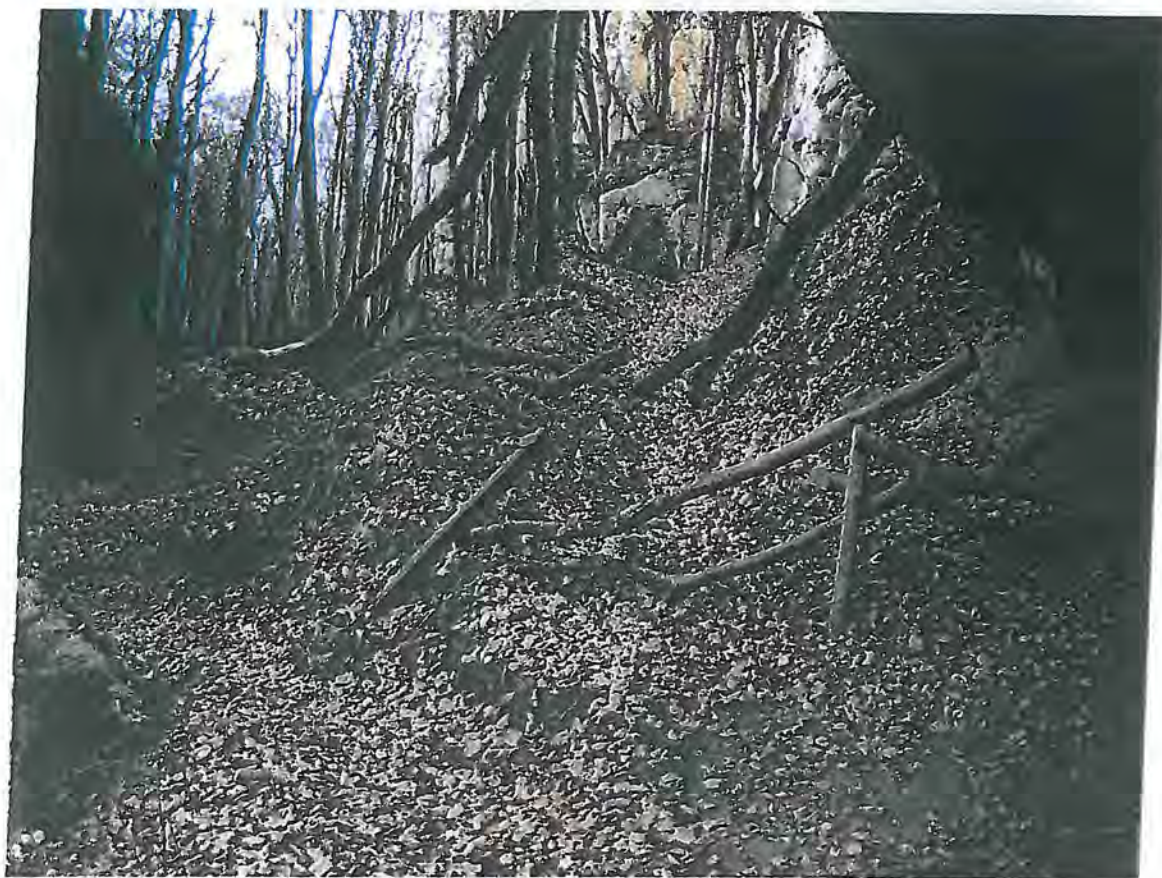
Photo 50: Les chemins de la RFI doivent être régulièrement nettoyés et dégagés
