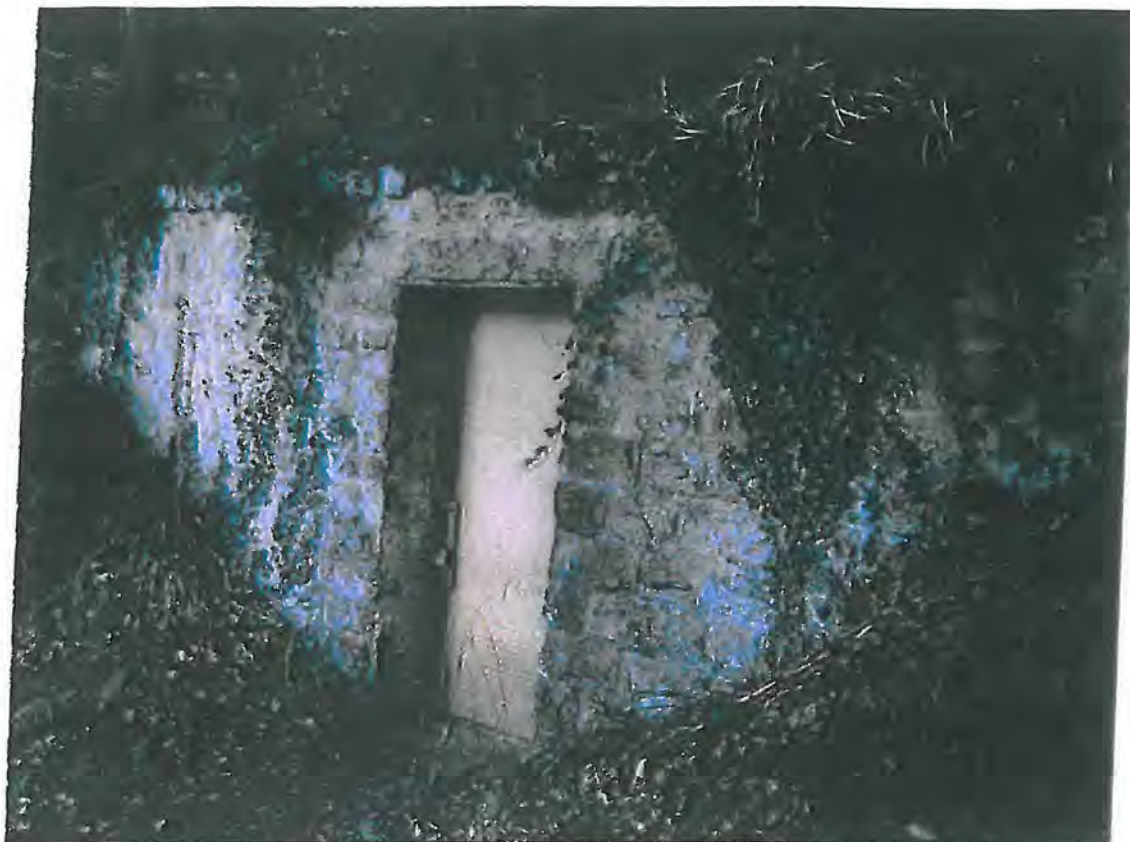
Photo 38: Réservoir d'eau au nord de la zone de captage, mais en-dehors de la RFI ©EFOR
