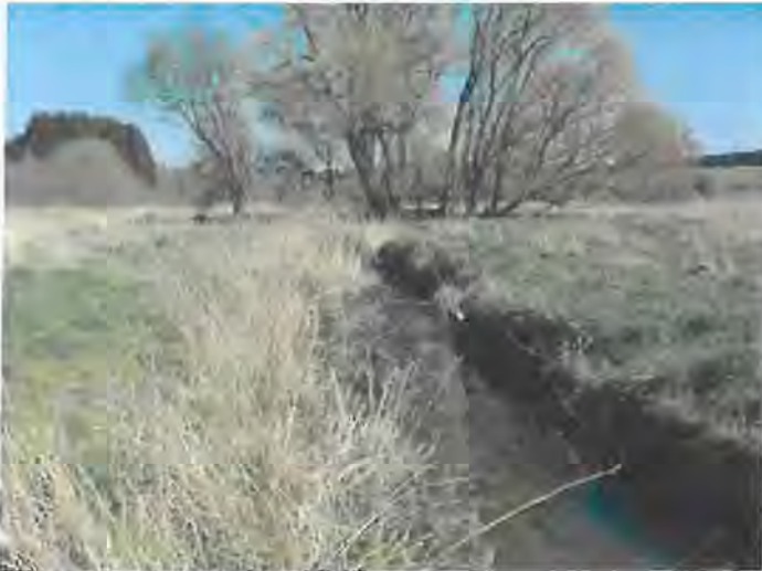
Abbildung 40. Begradigung der Woltz führt zu Tiefenerosion und Entwässerung der Fläche (BK_661108174). Eine Renaturierung ist hier wegen mangelnder Wasserqualität derzeit nicht möglich.
