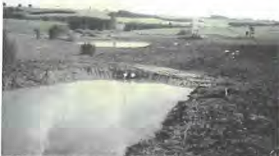
Abbildung 3. Die Ausbaggerung der Weiher in Belzourn 1994.
