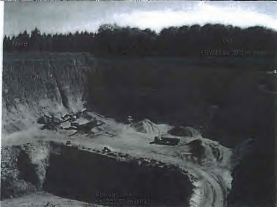
Abbildung 7: Abbausohle ca. 327,50 m+NN am 03.07.2014 im östlichen Teil des Steinbruchs in der Erweiterungsfläche A (vgl. Abb. 1)
