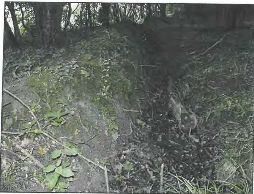
Abbildung 5: Graben an offen gelegtem Schichtwasseraustritt am Rand des Geyersbesch
