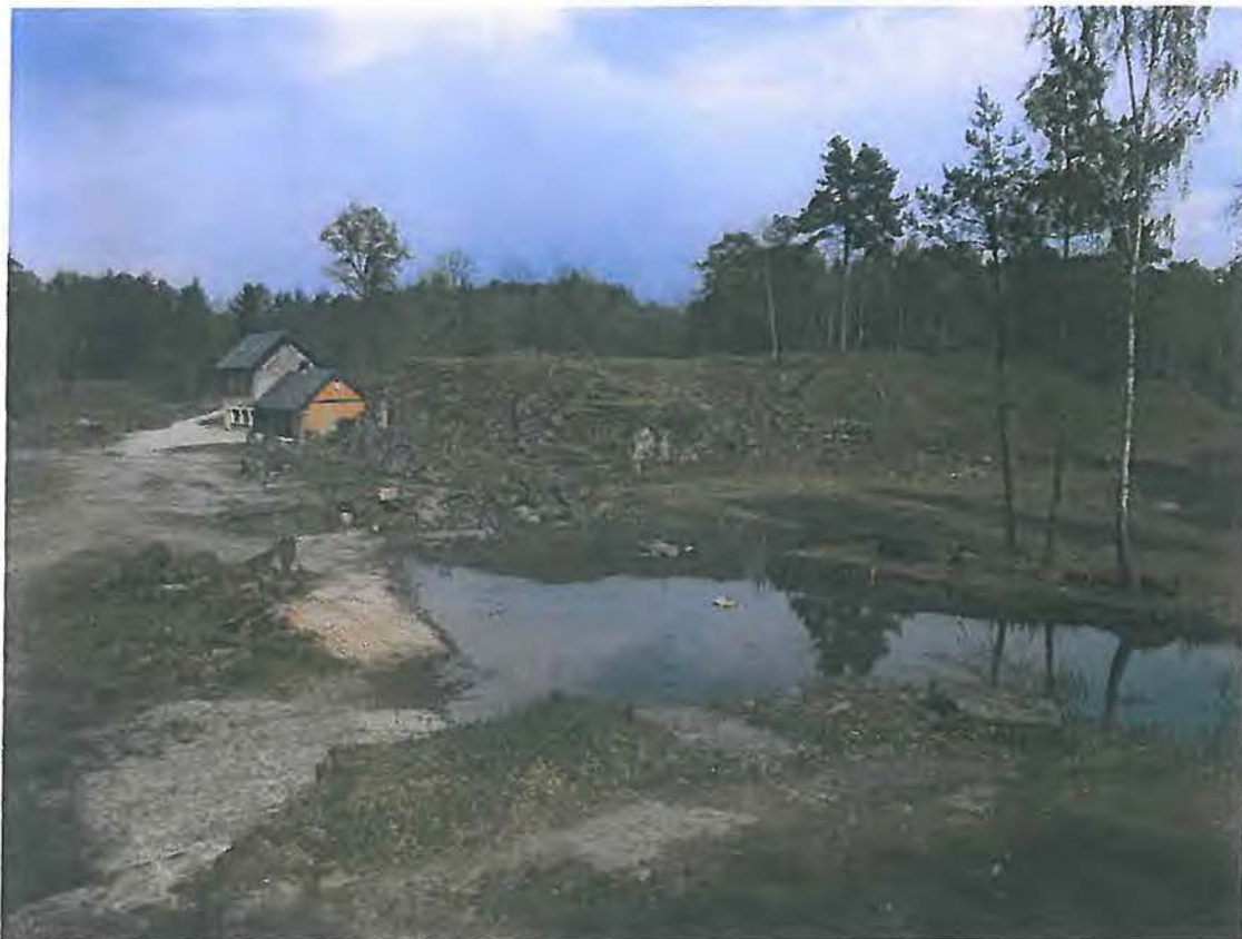
Foto 4: Blick aus südwestlicher Richtung auf den Tümpel S1, die renovierten Gebäude und die entbuschte Fläche 5b (24.04.14)
